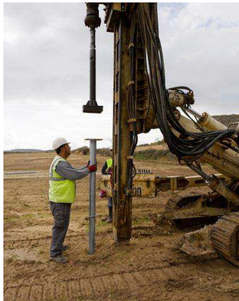
Imagen del proceso de atornillado.
