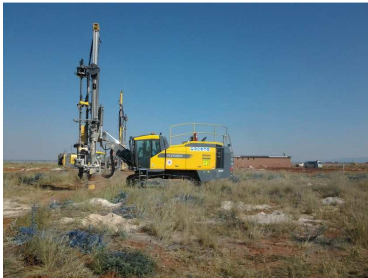
Vista de la perforadora Atlas Copco.
