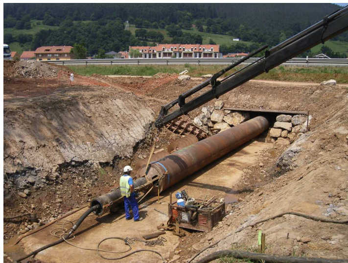
Vista general de la obra.
