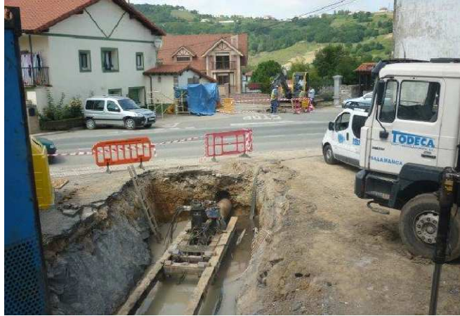
Vista general de la Obra.
