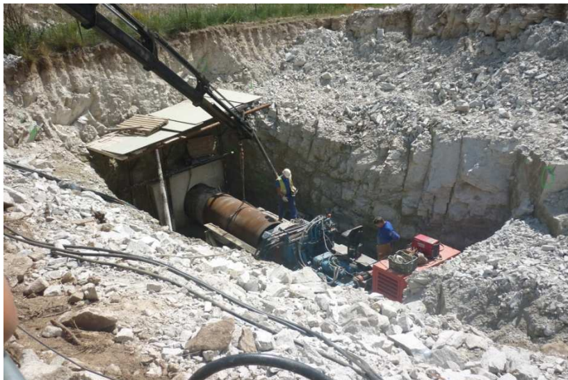
Vista general de una obra.
