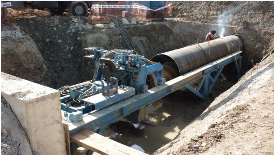
Soldadura de las tuberías instaladas.
