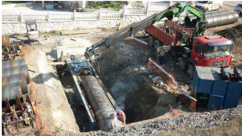
Colocación de los equipos de perforación.
