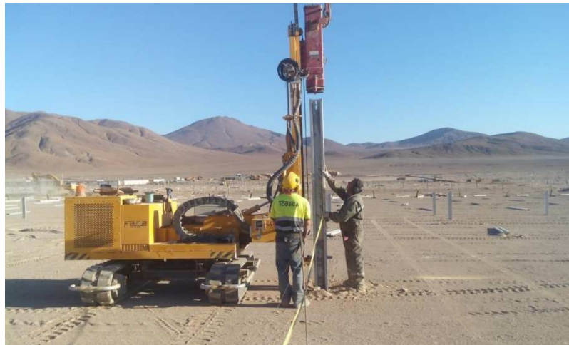
Una de nuestras Faga MHP-750W trabajando en labores de hincado en el Desierto de Atacama (Chile).
