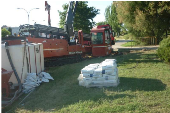
Sacos de bentonita al lado de la mezcladora.
