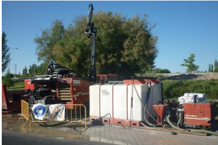
Vista general de los equipos necesarios para la perforación.
