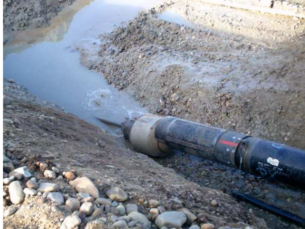
Vista del proceso de lanzamiento de la tubería.
