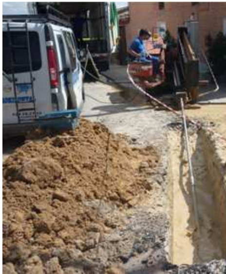
Vista de la ejecución de la perforación piloto.
